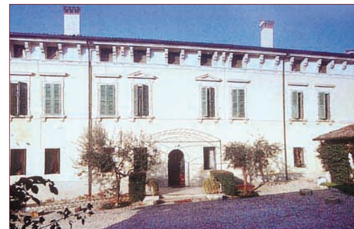
Villa Maffei – Cavaggioni – Villardi.
